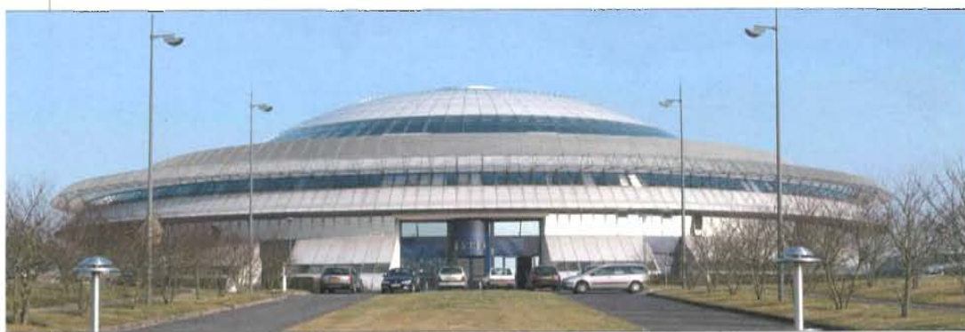
Le bâtiment de la technopole construit par les architectes Jacques CHARON et Yves BAYARD. Cette structure élégante et futuriste marque le territoire ; elle reçoit ainsi, le 25 mars 2002 le label «patrimoine du XX e siècle».
