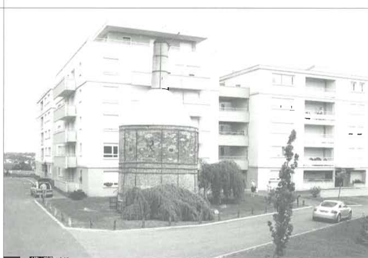
La résidence du parc Montjovis en 2002.
