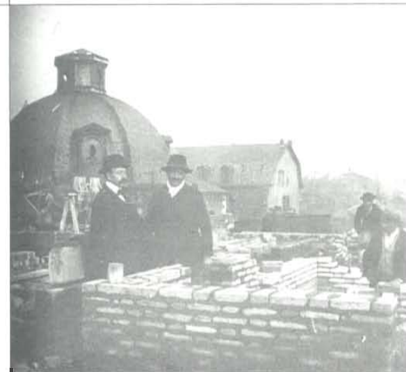
L'architecte E. Jouhaud de Verdier en visite sur un chantier de construction rue François-Chénieux, non loin du dôme de la chapelle de la Visitation, v.1910 Coll. part.
