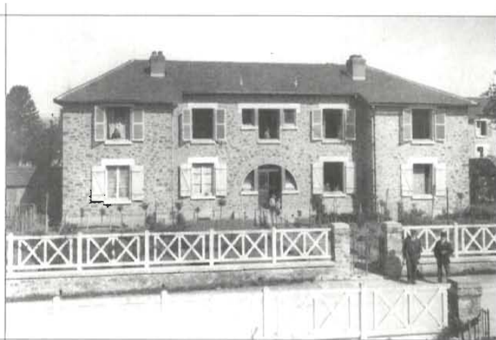
Cité Beaublanc Vue de la façade d'un logement, v. 1925 54 x 65 cm (cliché 30 x 40 cm). Archives Municipales de Limoges - 9 Fi n.c.
