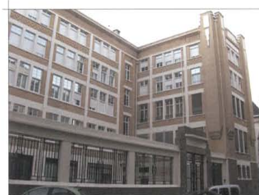
Immeuble des P.T.T., aujourd'hui résidence du Collège, rue Edouard-Vaillant, Louis-Charles-Henri Geay, v. 1931.
