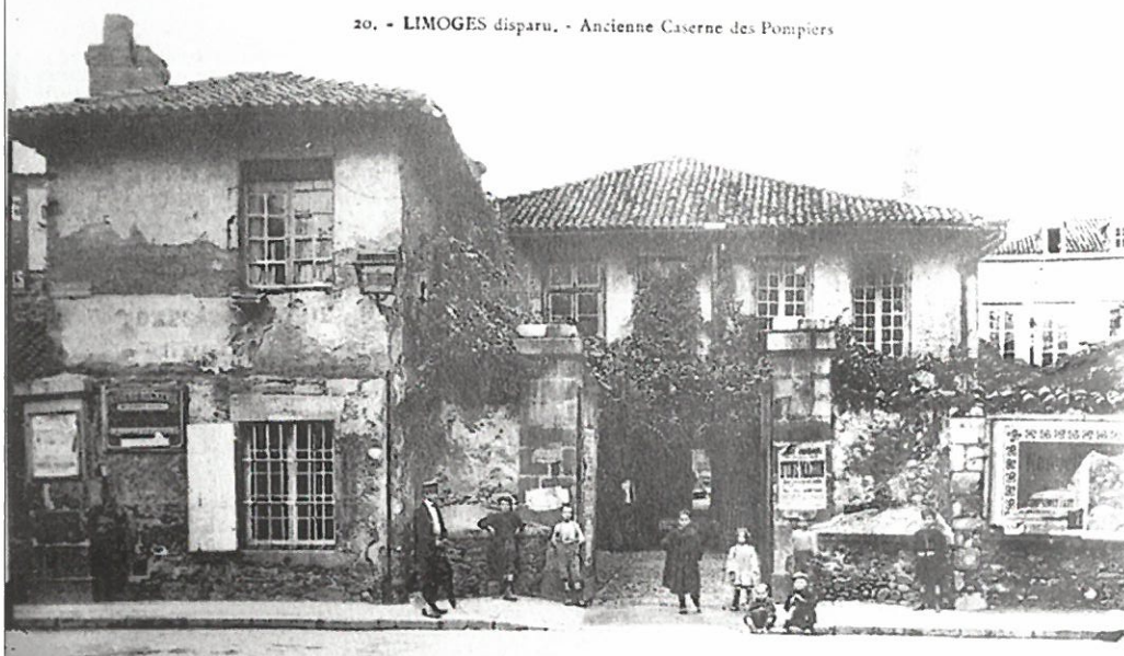
Vue de la caserne des pompiers de la Monnaie avant démolition Façade, v. 1910 Coll. P. Colmar.
