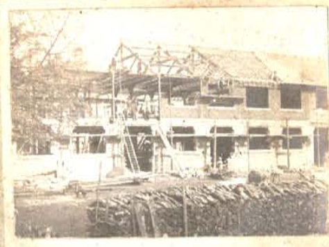
1901-1902 - Usine G.-D.-A. - Façade côté de la Vienne.
