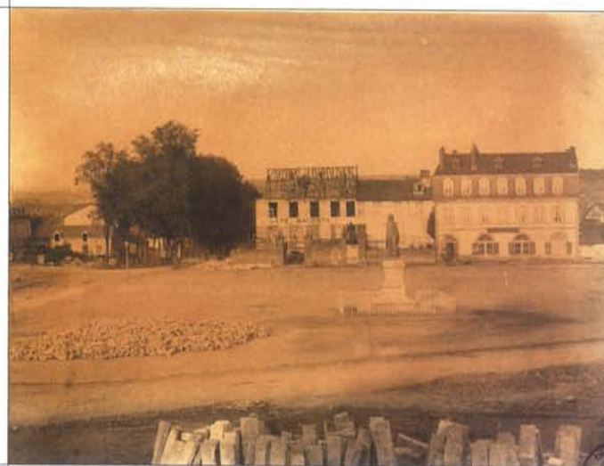
Vue de la place Jourdan en travaux après rebouchage du tunnel ferroviaire S.d., fin 1861, 26 x 32 cm. Archives Municipales de Limoges - Fi n.c.
