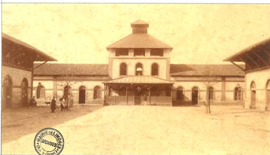
Ancien abattoir Vue de la façade, s.d., v. 1900 19 x 25 cm. Archives Municipales de Limoges - Fi n.c.
