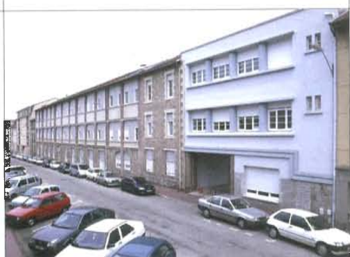
Vue actuelle de l'ancienne usine Heyraud, 8, rue Hoche. Service Régional de l'Inventaire
