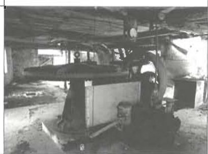
La turbine dans l'ancien bâtiment de filature aujourd'hui disparue Service Régional de l'Inventaire
