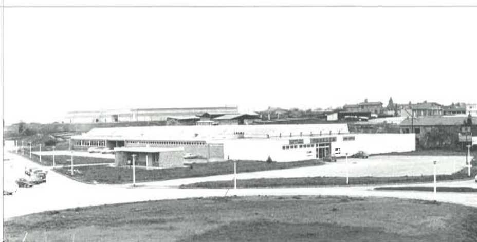
L'architecture contemporaine des usines, comme celle-ci, visible sur la zone industrielle Romanet, est caractérisée par l'utilisation de matériaux industriels, ultra légers et résistants, et la recherche d'une fonctionnalité maximale. La géométrie systématique des formes, l'uniformisation des ouvertures ainsi que l'accentuation formée par le développement horizontal des bâtiments évoquent selon les critiques courantes, les lignes d'une «boîte à chaussure». Cependant, elles expriment parallèlement la modernité essentielle et indispensable à l'image d'une entreprise compétitive et innovante. (Archives municipales de Limoges, Fin.c.)
